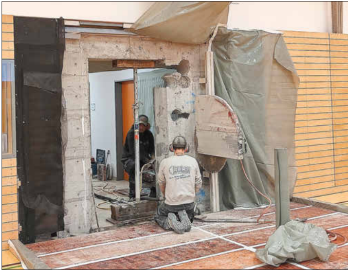
Betonschneiden
