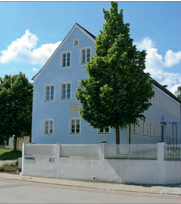
Das Gemeindehaus, der ehemalige Zehentstadel
